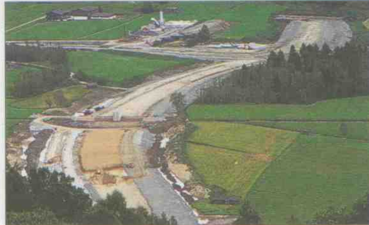
Rascher Baufortschritt beim Querdamm.
